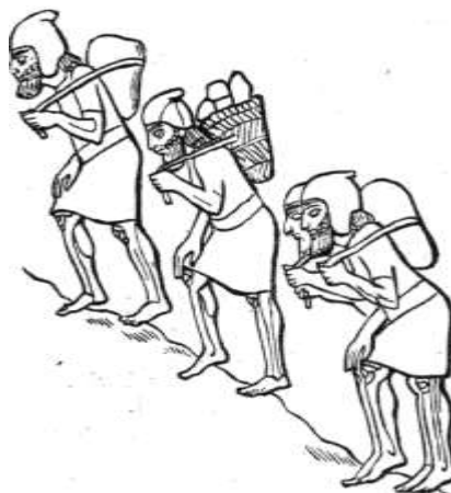
Izraelci pracují na stavbě paláce assyrského krále Sargona. Reliéf z Chorsabadu.
